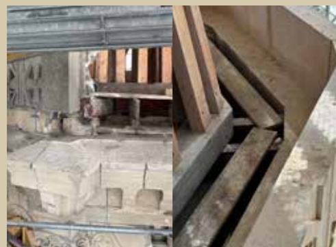
Travaux sur le clocher
